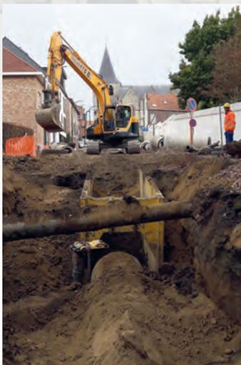
rant du mois de novembre, la 2<sup>e</sup> phase débutera dans la foulée. Cette phase regroupe les travaux aux abords de l'église. Deux égouts séparés y seront installés, un pour les eaux usées et l'autre pour les eaux pluviales. Cette mesure a pour objectif d'éviter les inondations. Des travaux seront également réalisés à la voirie et
