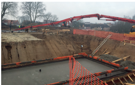
De werken voor het optrekken van de nieuwbouw zijn in december van start gegaan.
