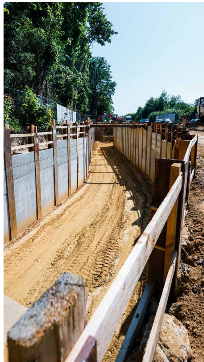
Fietshelling aan de Welriekendedreef in aanbouw
