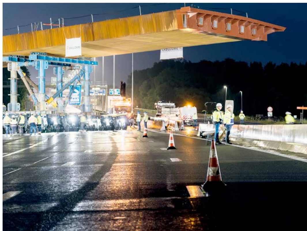
Installatie brug Hector Henneaulaan
