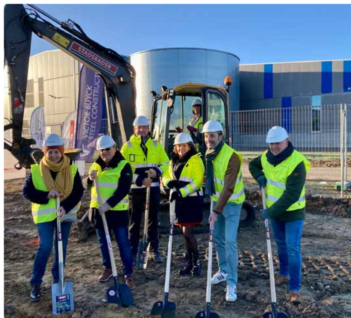
Eerste spadesteek voor de fietsers- en voetgangersbrug over de A201
